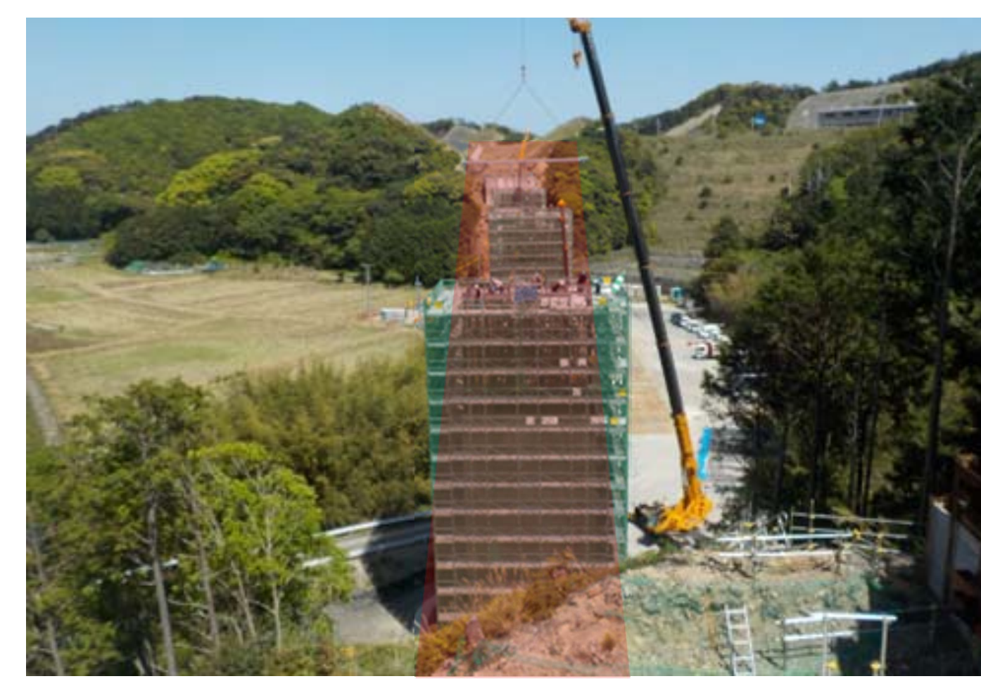
⑧ 串本町サンゴ台(サンゴ台高架橋) 紀南河川国道事務所
