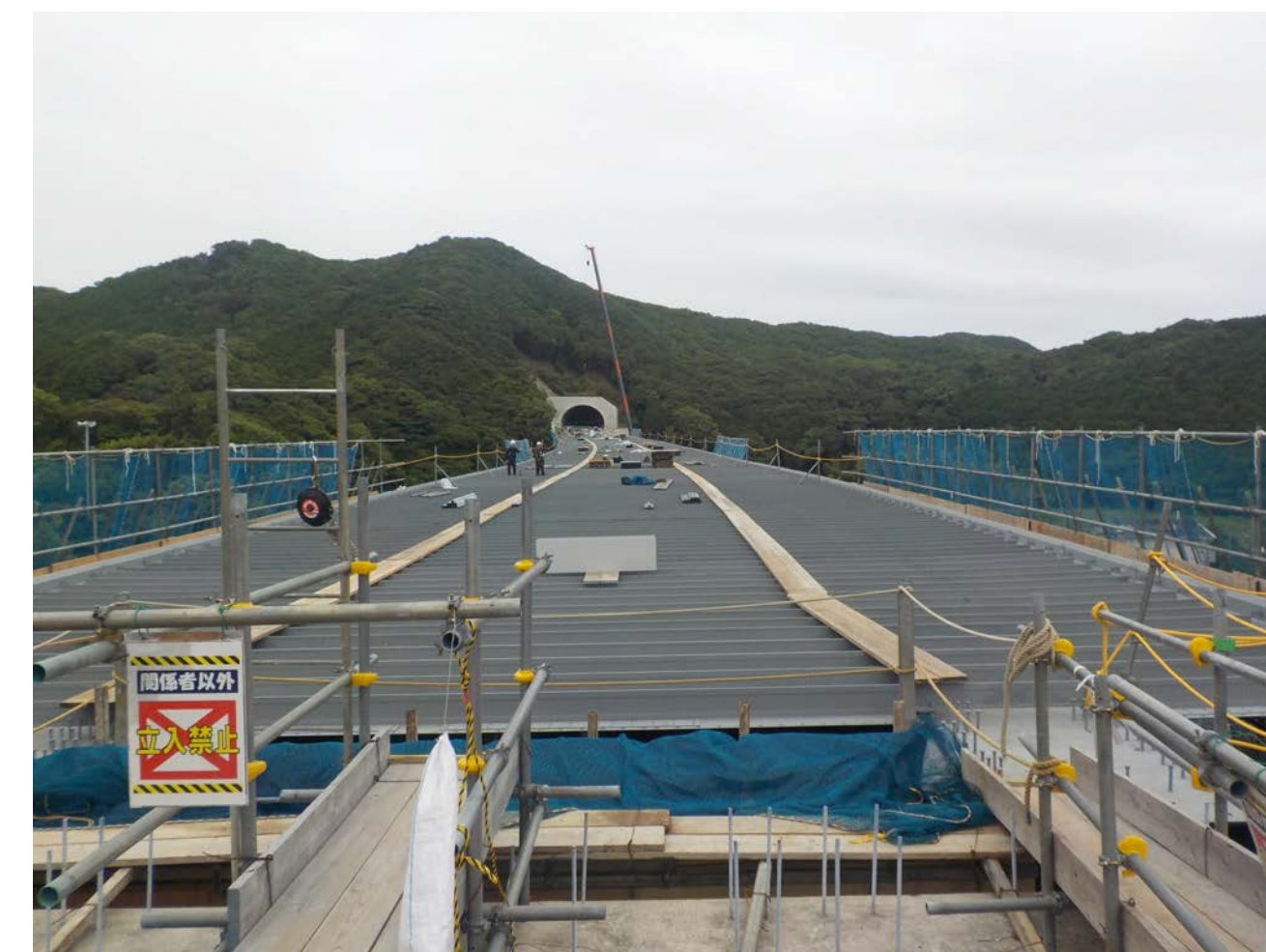
⑦ 串本町高富(高富川橋)
