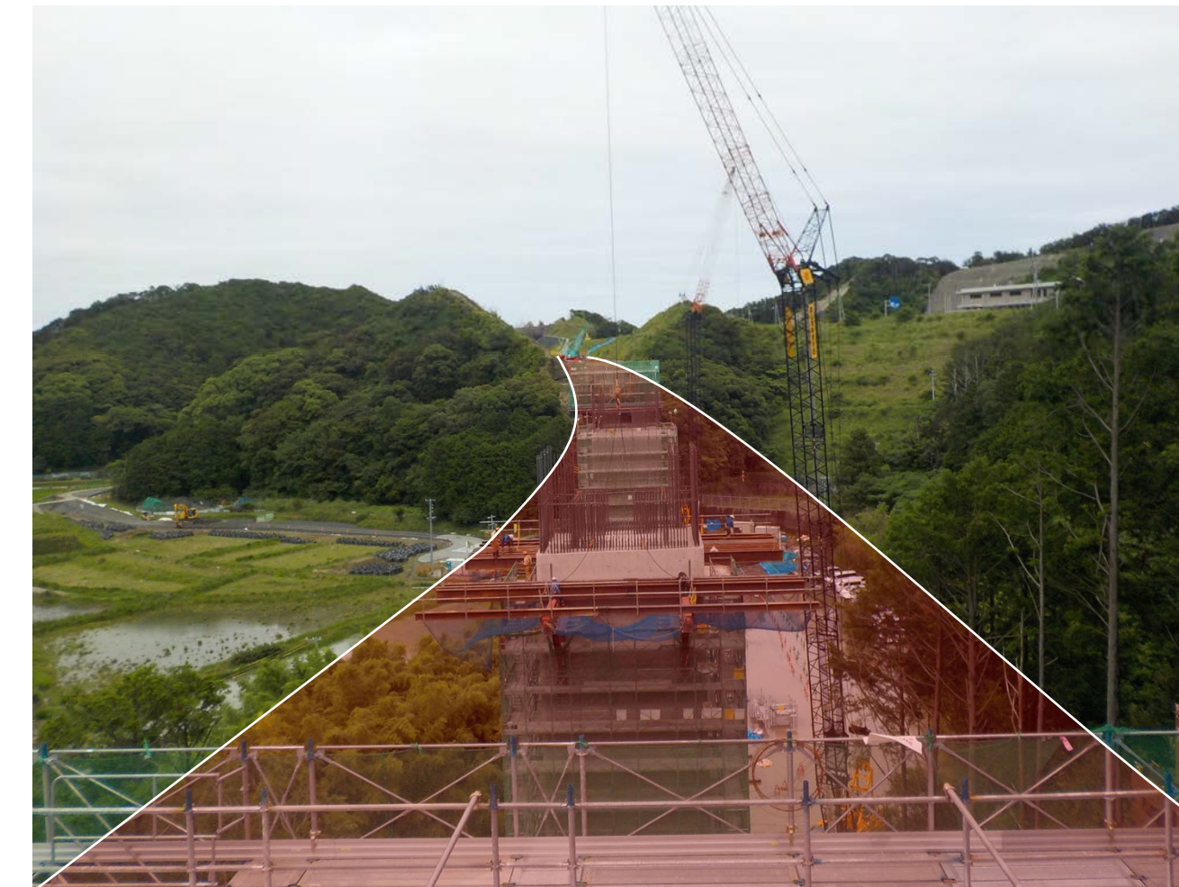
⑧ 串本町サンゴ台(サンゴ台高架橋) 紀南河川国道事務所
