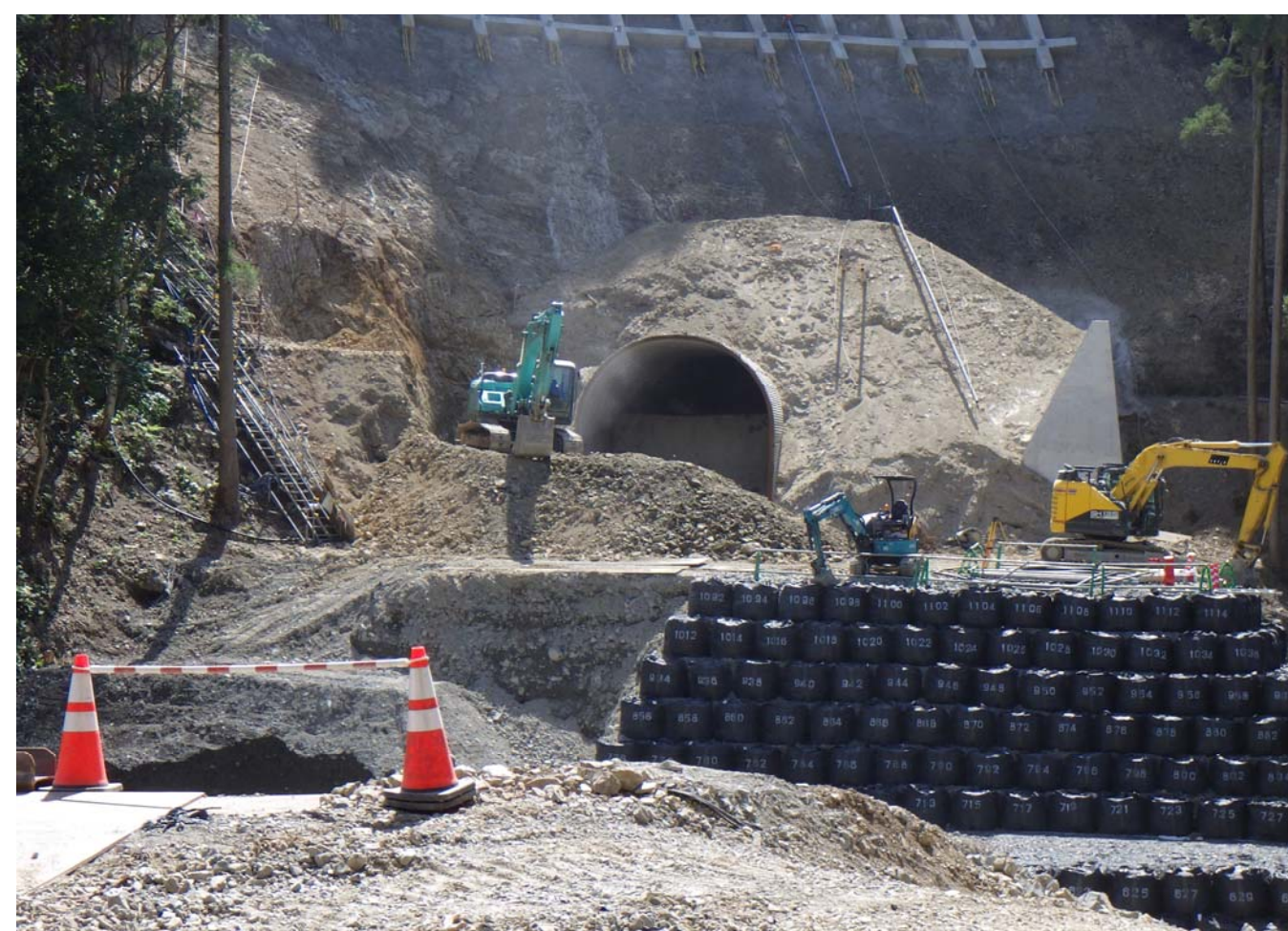
①すさみ町里野(宇の平見トンネル)
