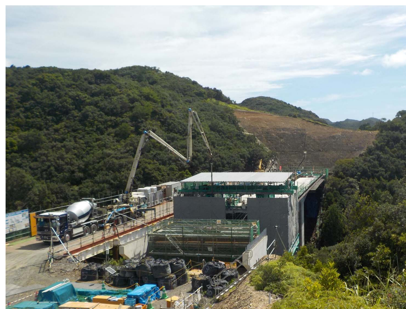
⑤串本町高富(東雨川第一橋)
