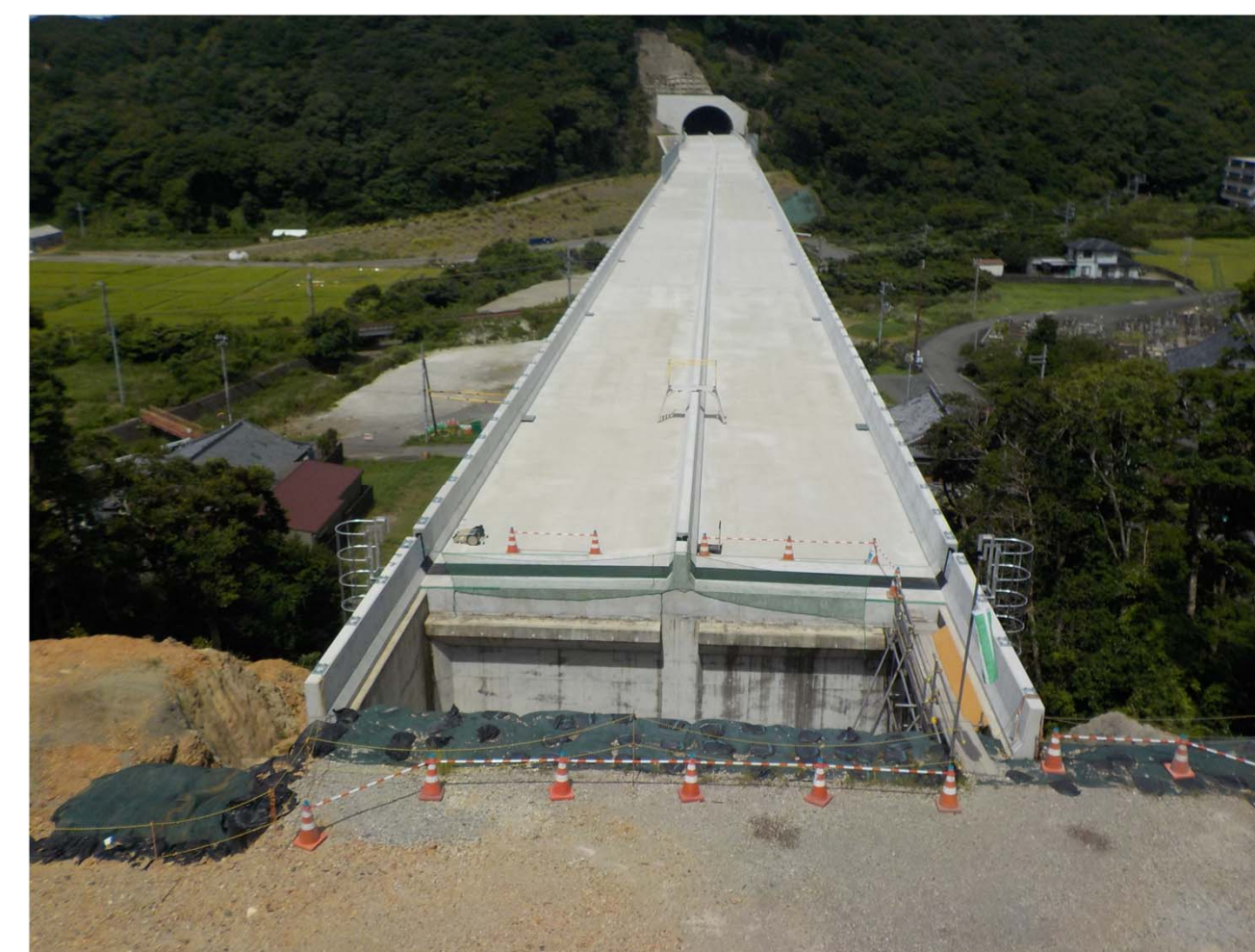
⑦串本町二色(二色川橋)
