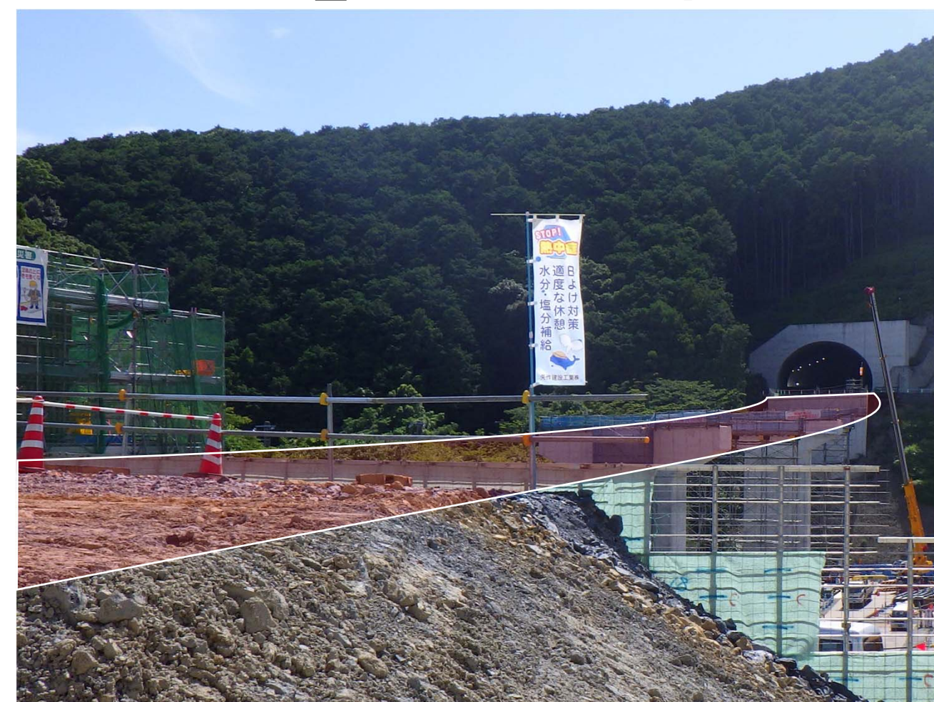
②すさみ町里野(里野西池川橋)
