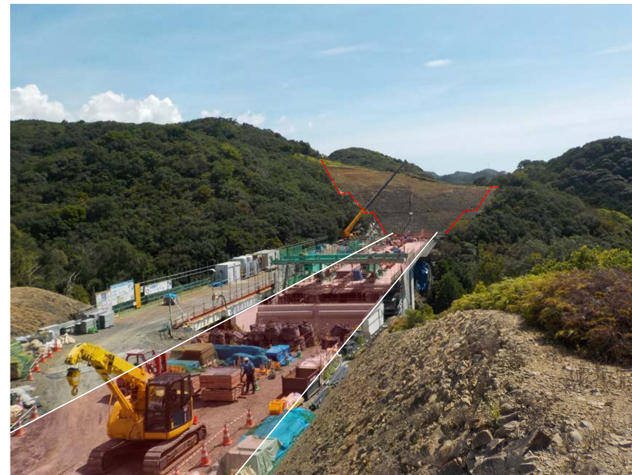
⑦串本町高富(東雨川第一橋)
