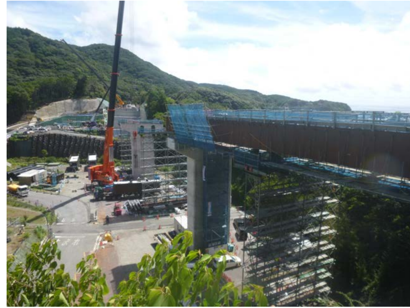
②すさみ町里野(里野西池川橋)
