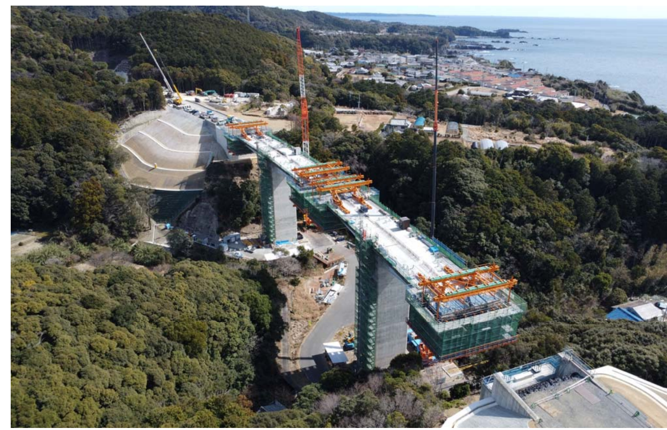
②串本町和深(熊谷川第二橋)
