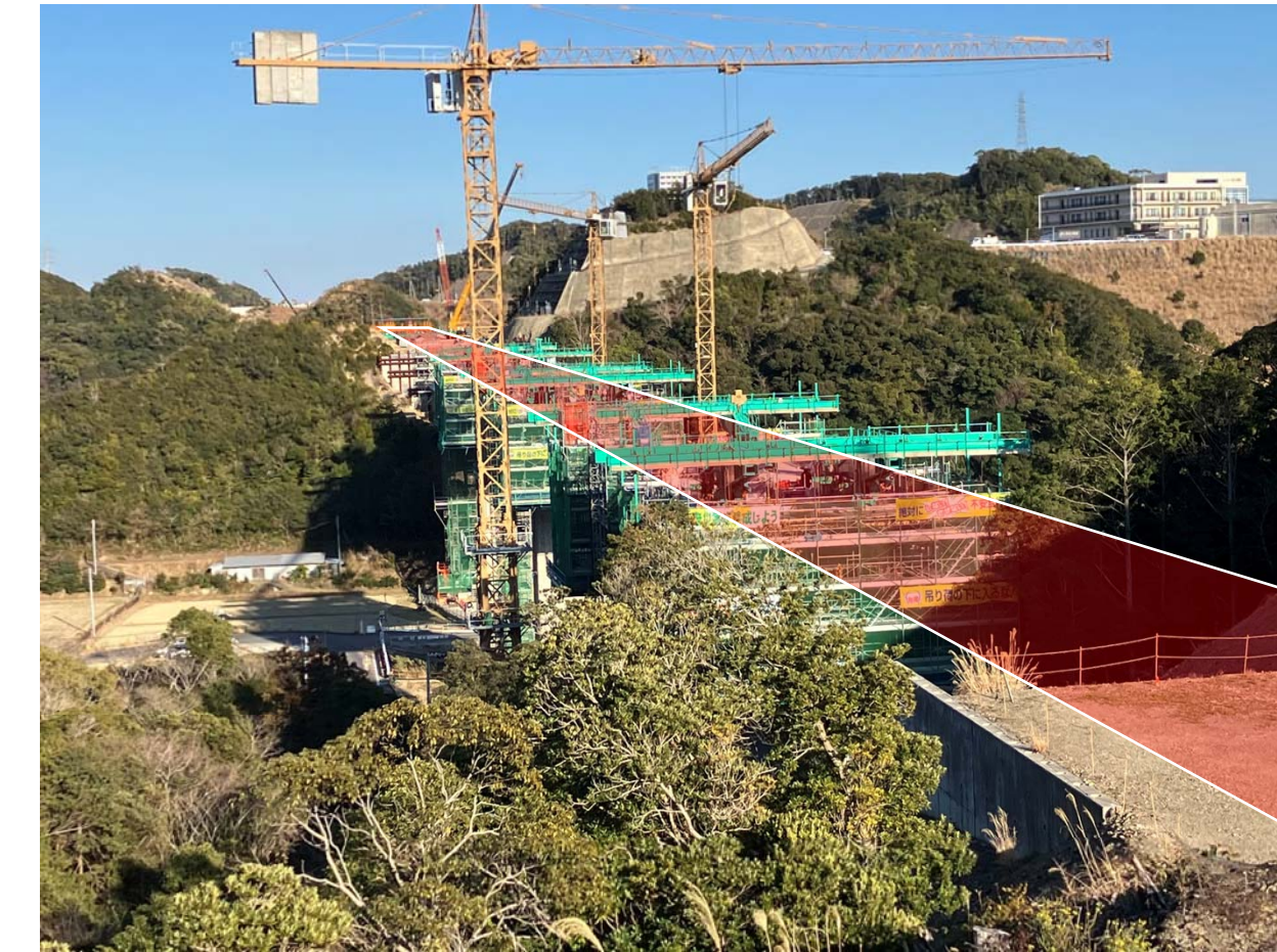
⑦串本町鬺野川(鬺野川橋)
