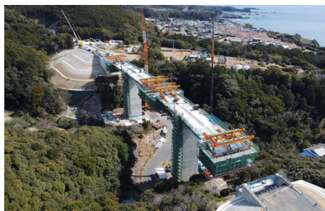
②串本町和深(熊谷川第二橋)
