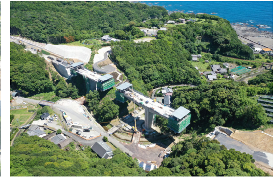
④串本町田子(田子川橋)
