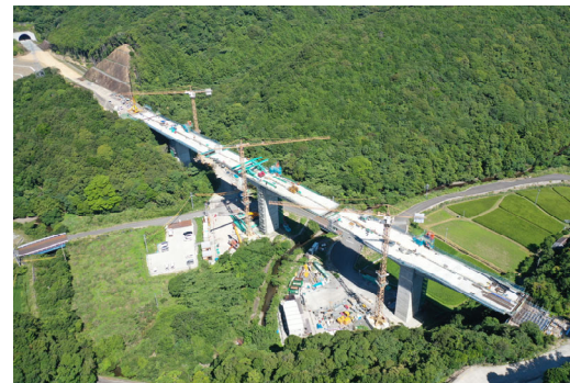
⑦串本町關野川(關野川橋)
