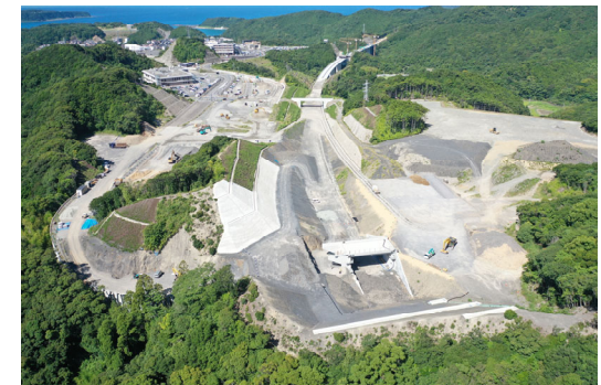
⑧串本IC仮称 (道路改良)
