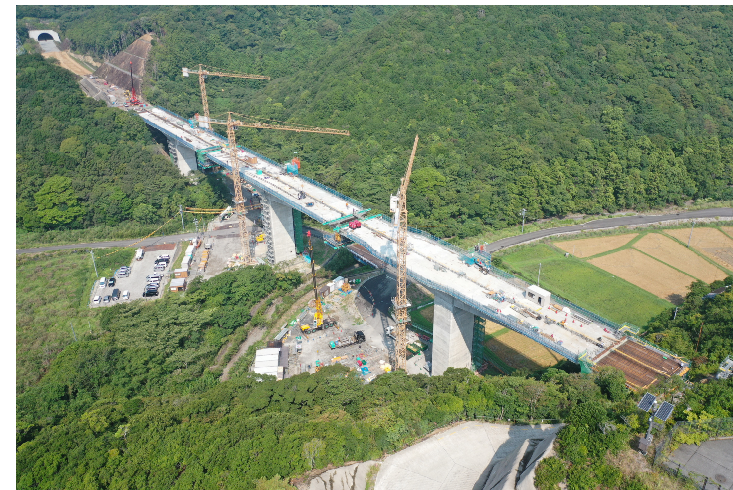
⑦串本町 關野川(關野川橋)
