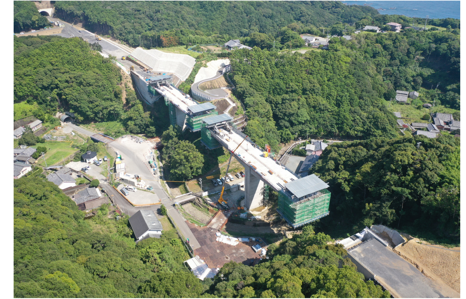
④串本町田子(田子川橋)
