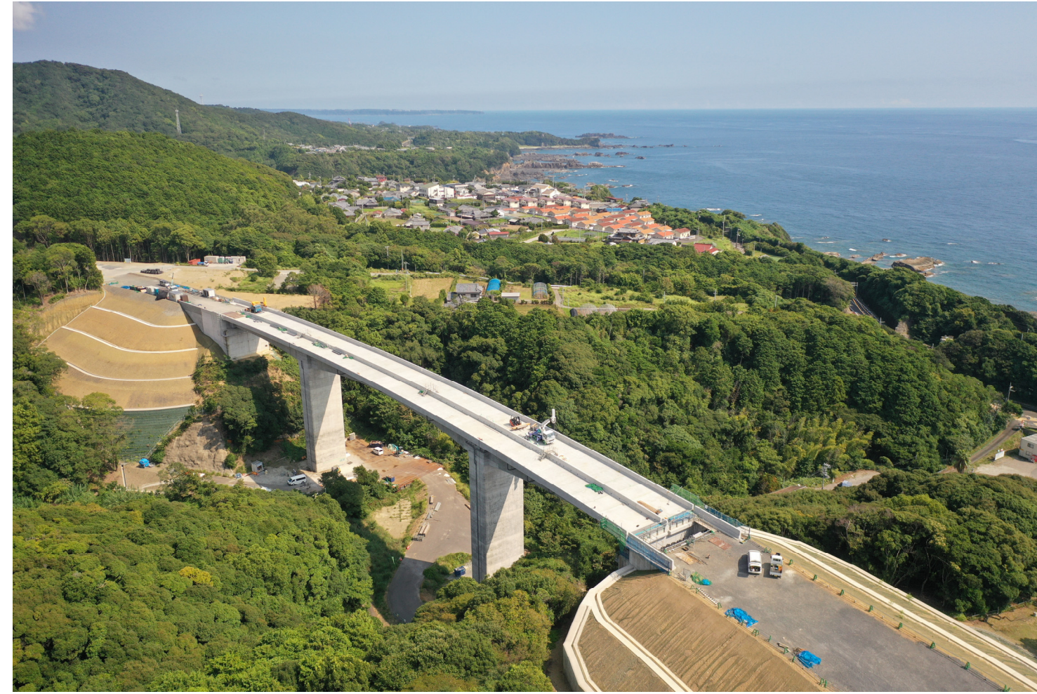
② 串本町和深(熊谷川第二橋)
