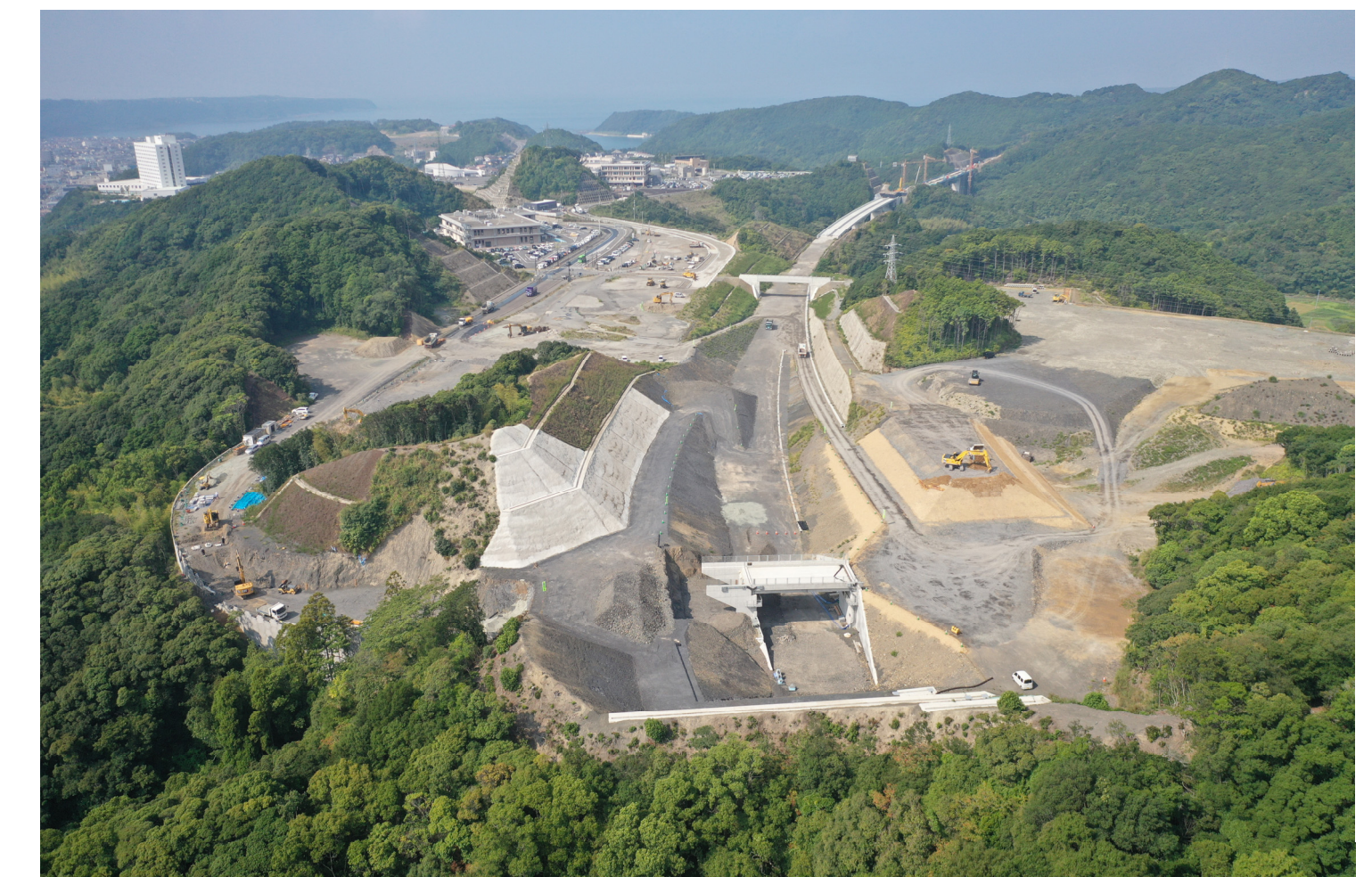
⑧串本IC仮称（道路改良）
