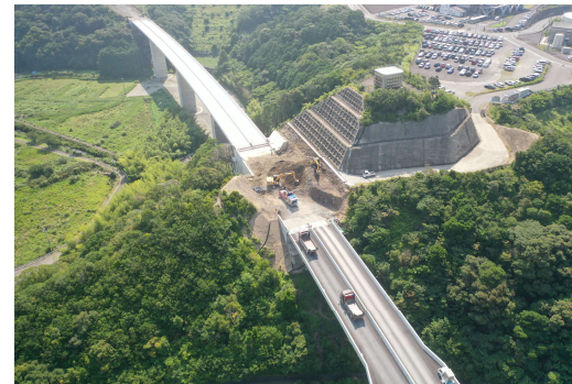
⑦串本町サンゴ台(道路改良)
