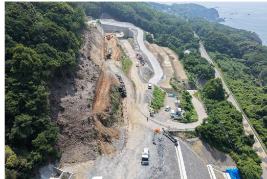
②すさみ町里野(道路改良)
