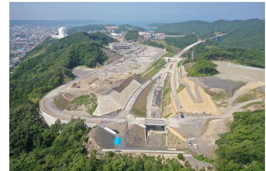
⑧串本IC仮称(道路改良)
