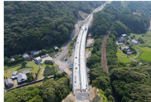
③すさみ町里野(小河瀬谷川橋)
