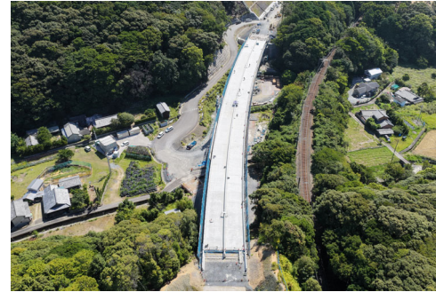
③すさみ町里野(小河瀬谷川橋)
