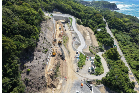
②すさみ町里野(道路改良)
