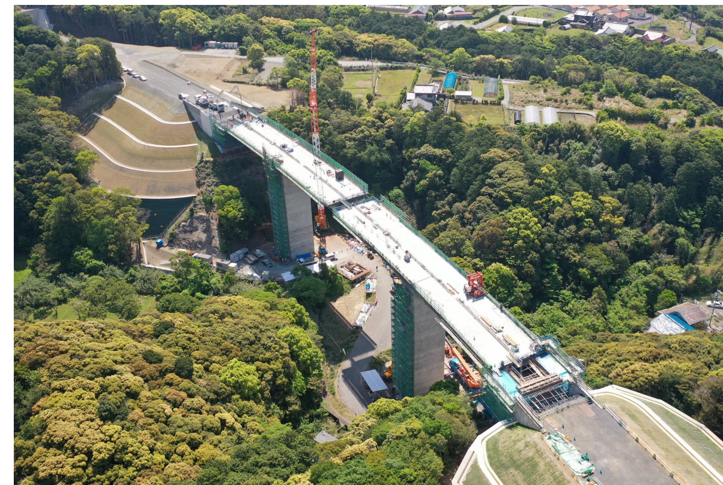
③串本町和深(熊谷川第二橋)
