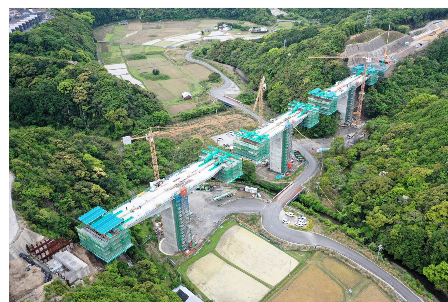
⑦串本町關野川(關野川橋)
