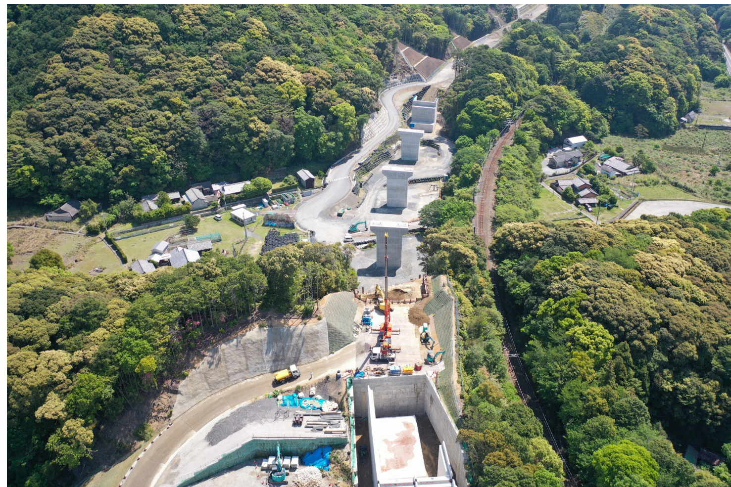
②すさみ町里野(小河瀬谷川橋)
