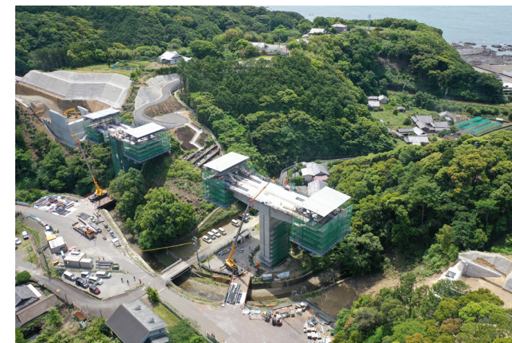
④串本町田子(田子川橋)
