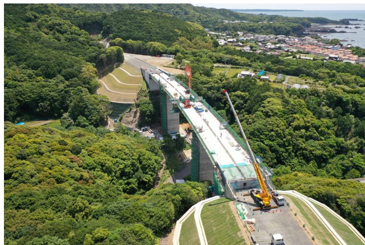
② 串本町和深(熊谷川第二橋)
