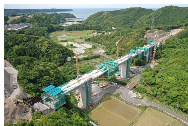
⑦串本町關野川(關野川橋)
