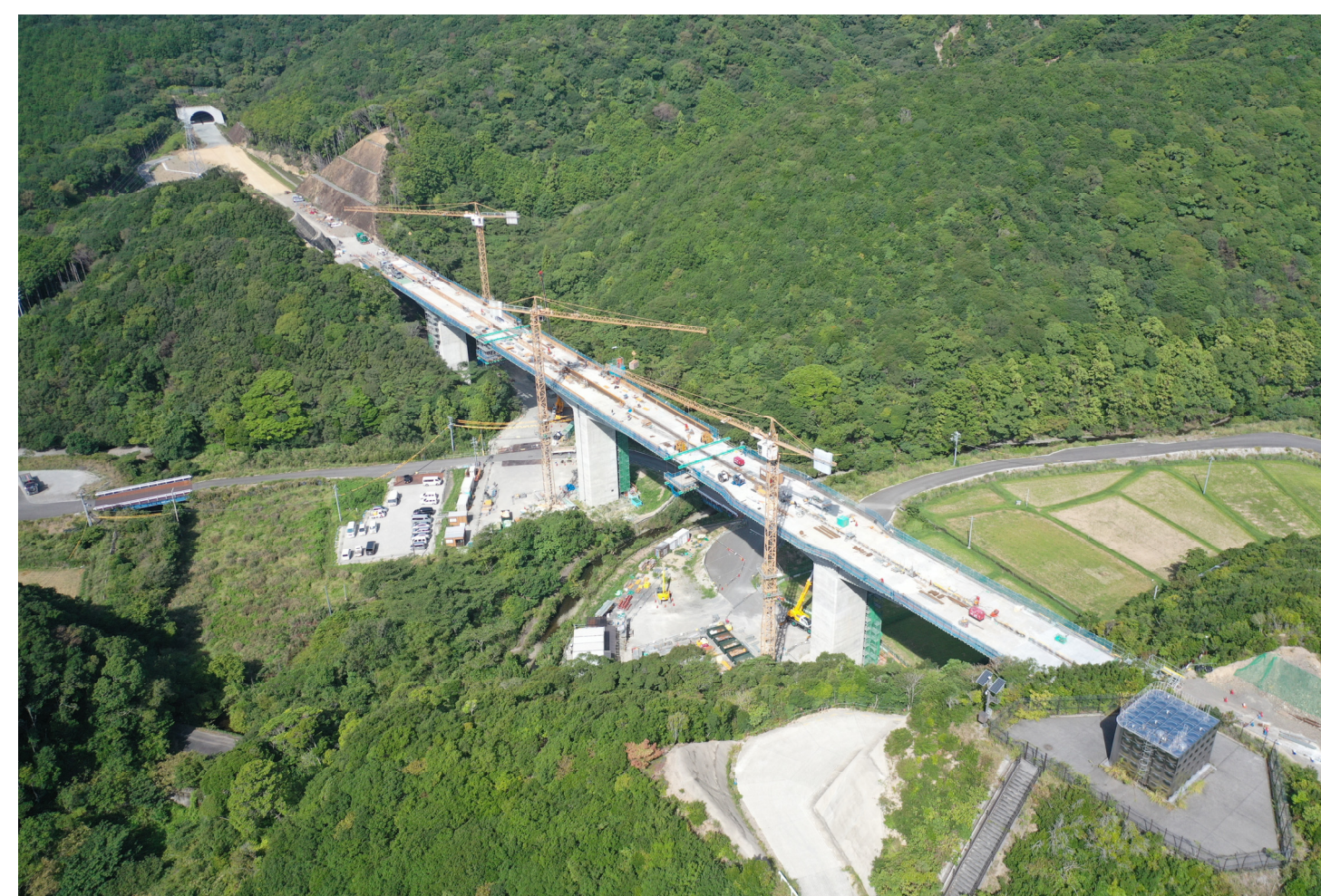
⑦串本町關野川(關野川橋)
