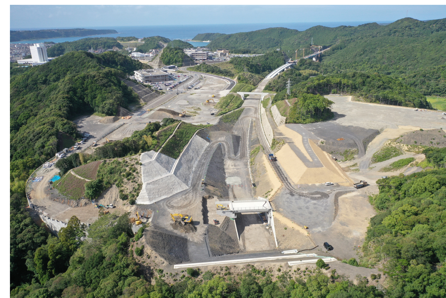
⑧串本IC仮称 (道路改良)
