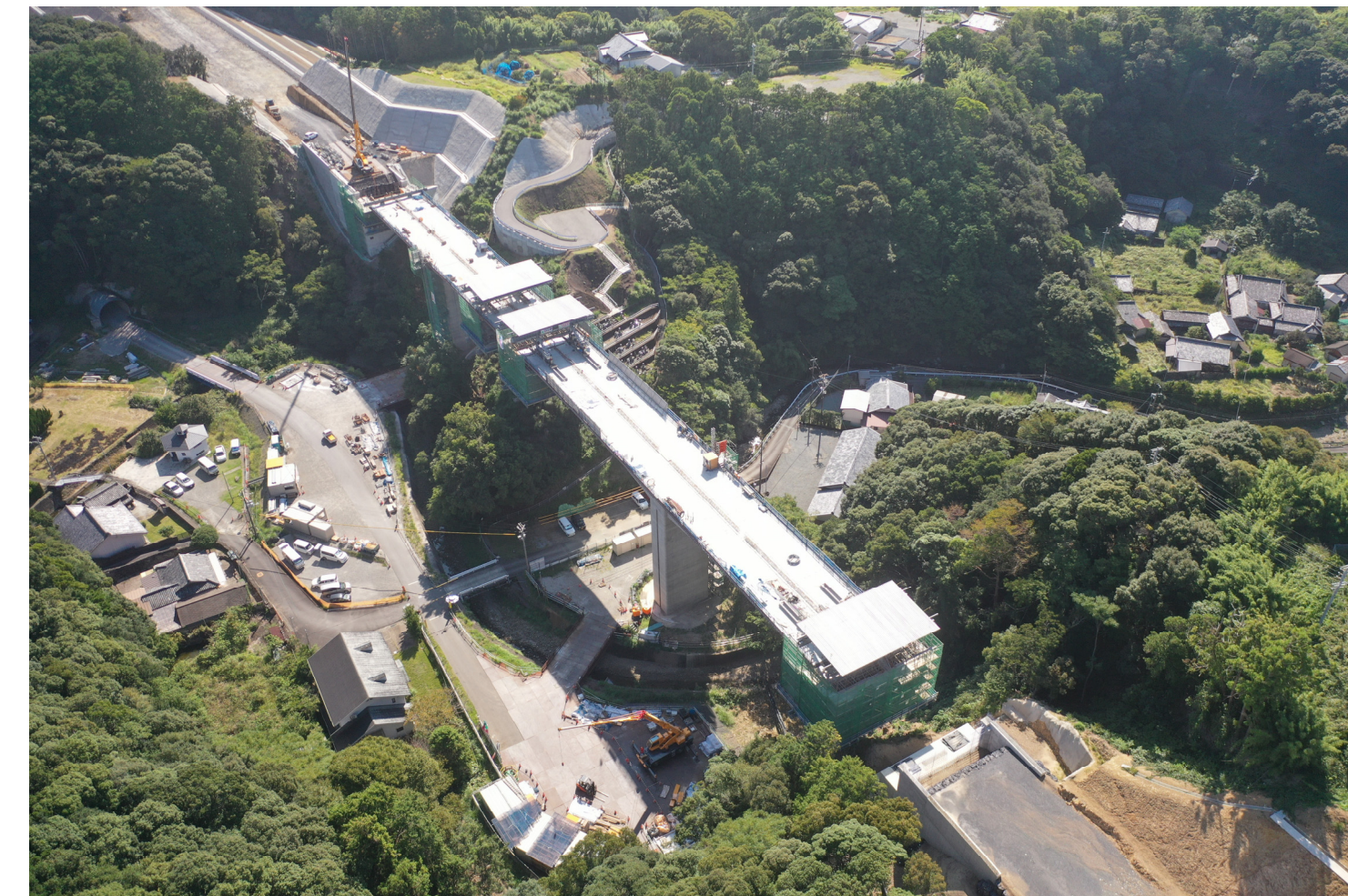
④串本町田子(田子川橋)
