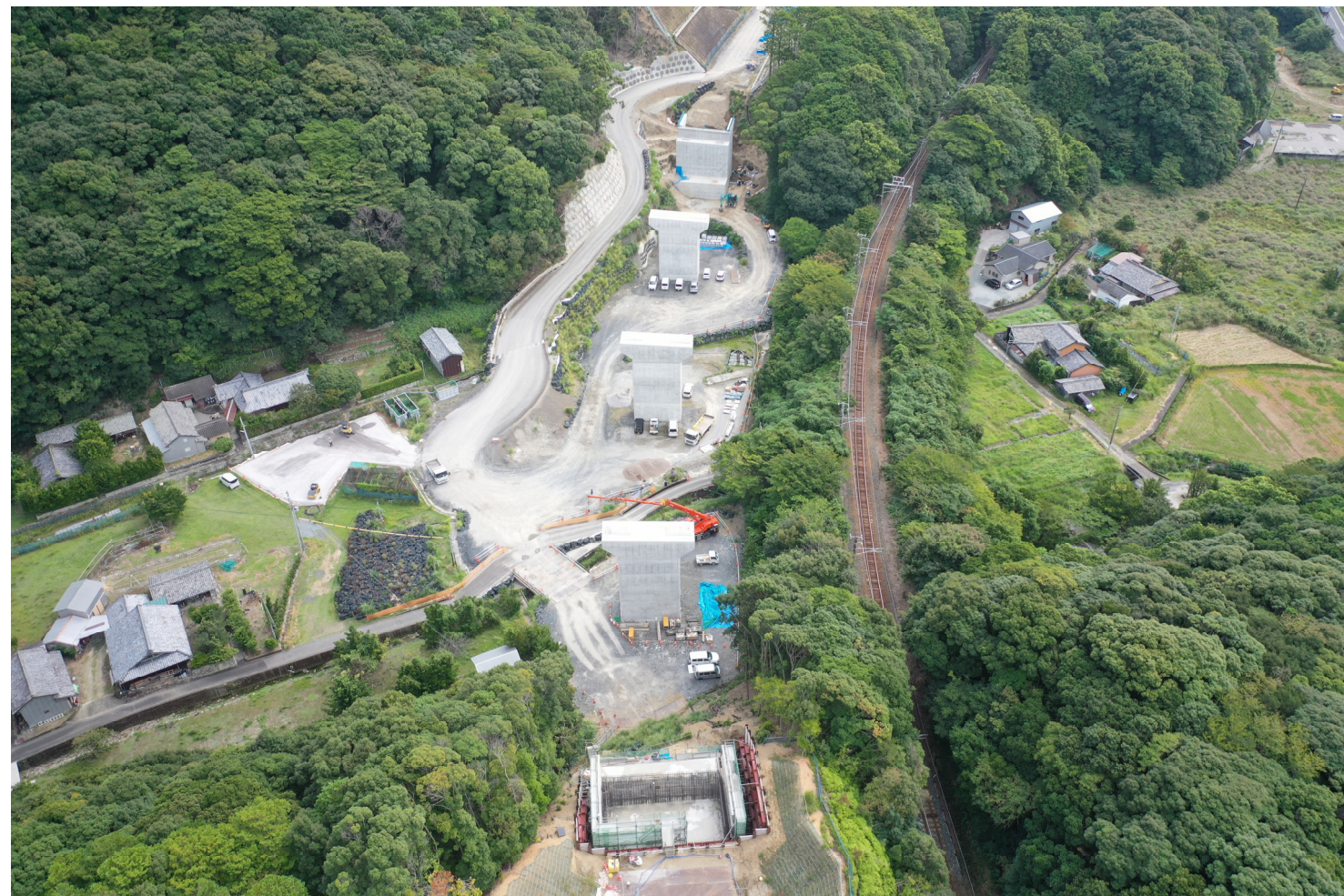
②すさみ町里野(小河瀬谷川橋)
