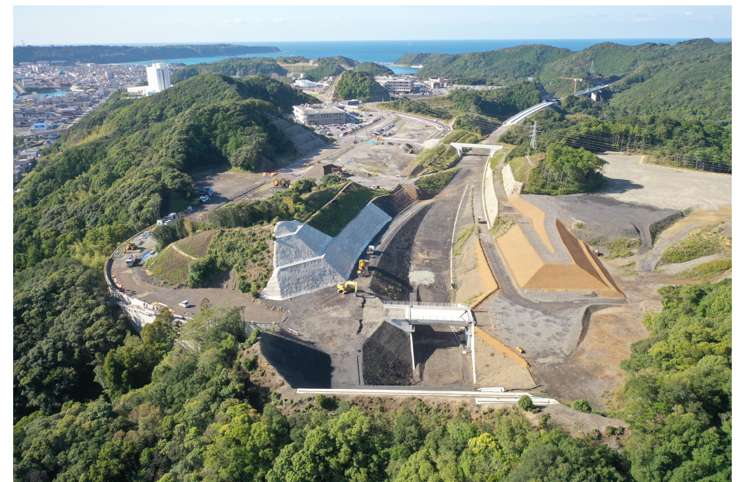
⑧串本IC仮称 (道路改良)
