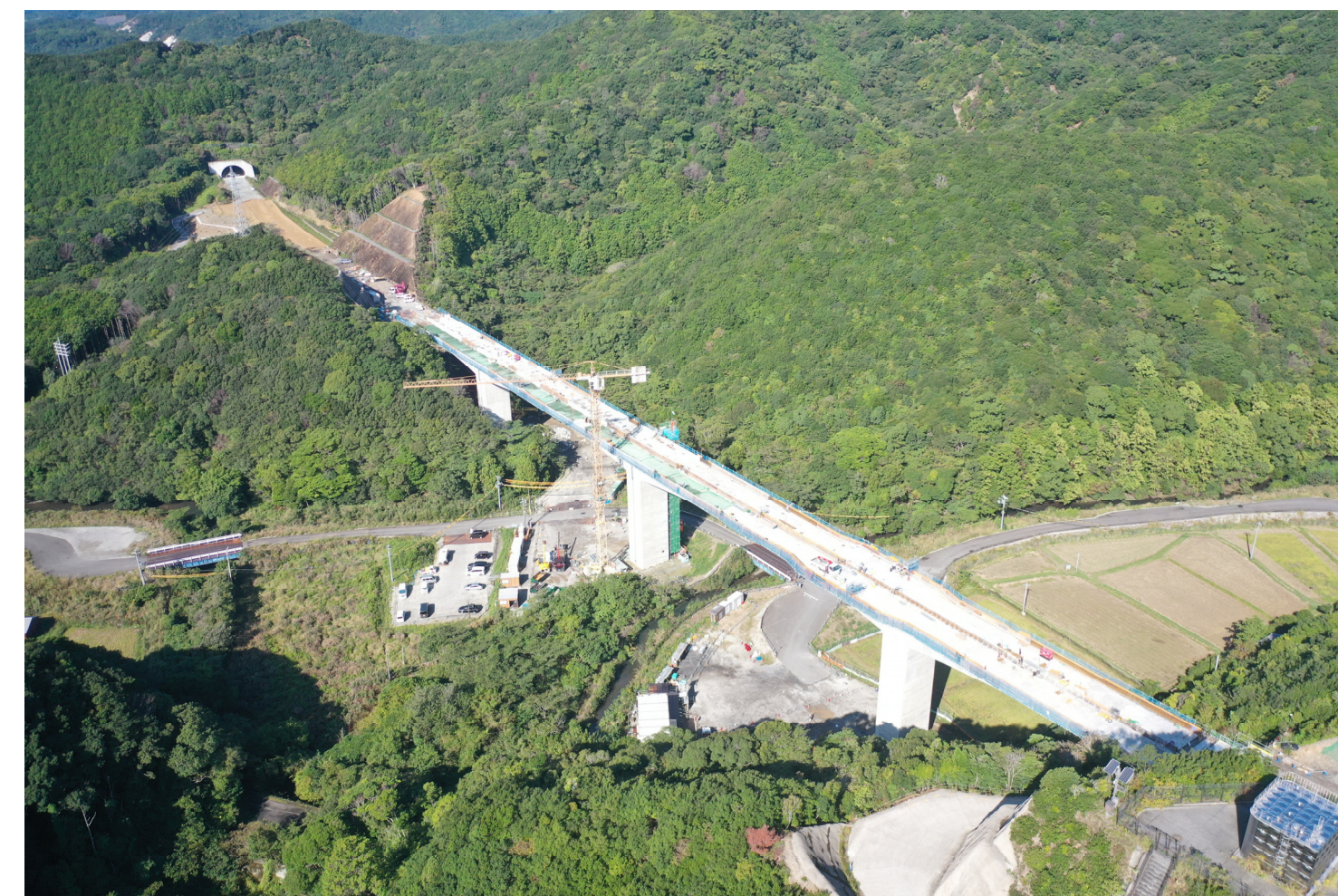
⑦串本町關野川(關野川橋)
