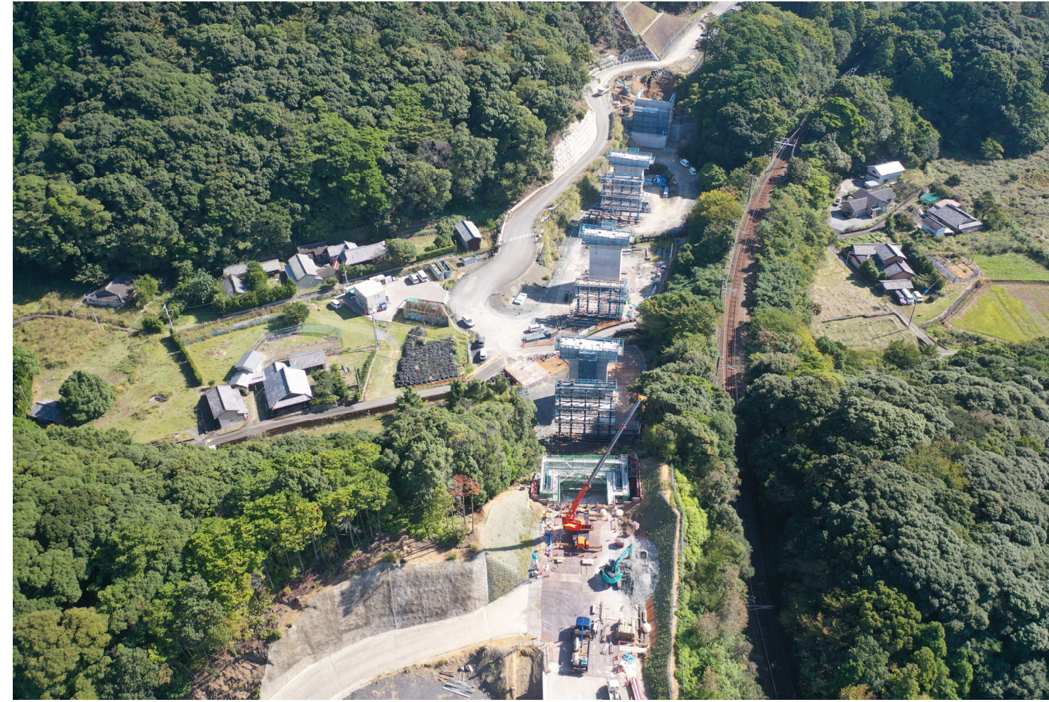
②すさみ町里野(小河瀬谷川橋)
