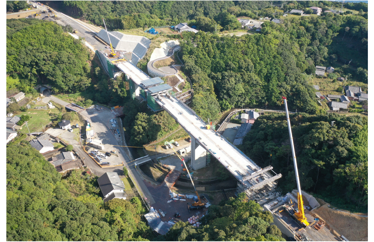
④串本町田子(田子川橋)
