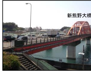
【写真②】新熊野大橋の渋滞状況
