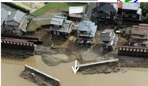
平成23年台風12号での相野谷川の輪中堤(特殊堤)の転倒状況(高岡地区)
