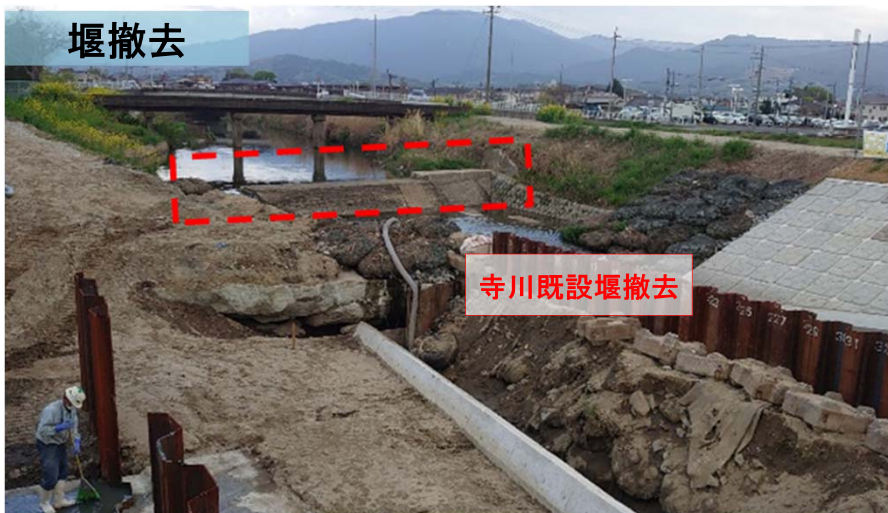
寺川堰撤去(桜井市大福工区)
