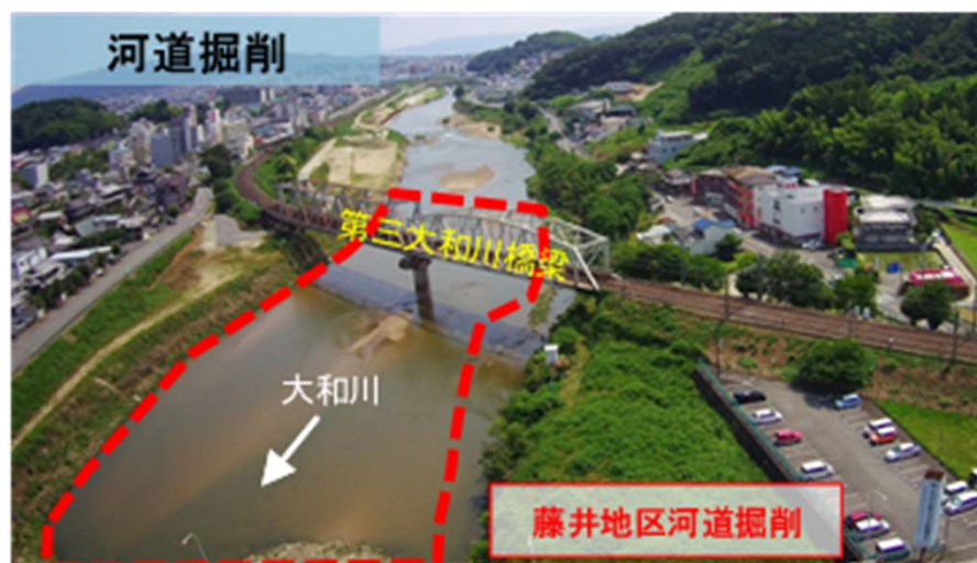
河道掘削(藤井地区)
