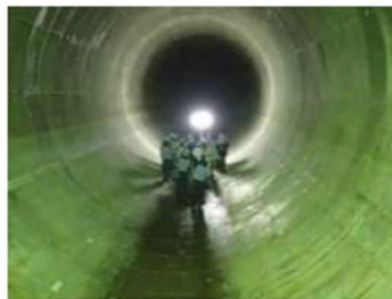
雨水貯留管の整備
