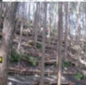
保安林整備と斜面筋工の設置による土壌の保全
