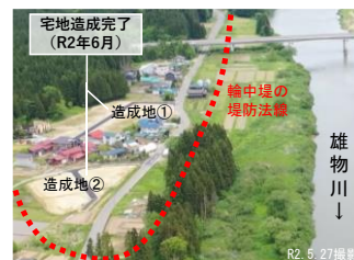
移転先宅地造成完了状況
