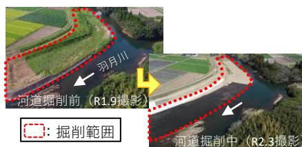
河道掘削(鹿児島県内川水系羽月川)
