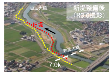
引堤(石川県梯川水系梯川)
