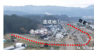
移転家屋の建設が進む状況
