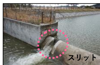
▲スリットの設置状況
