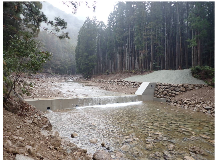
治山ダム実施箇所(熊野市)
