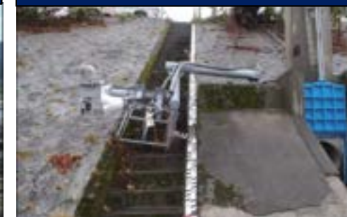
倒壊した新宮市船町の監視カメラ
