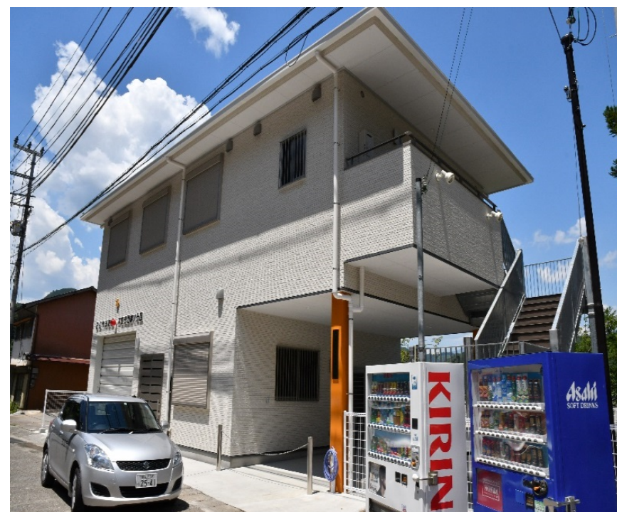
請川地域防災拠点施設
