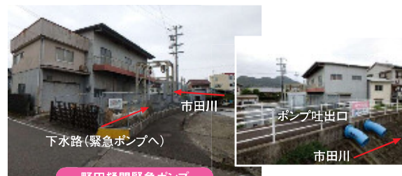
野田樋門緊急ポンプ
