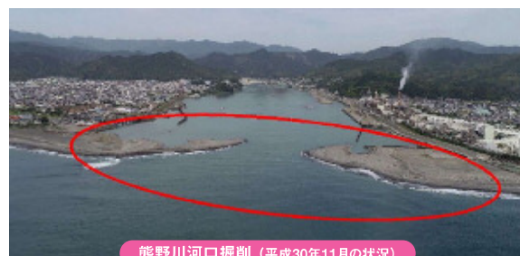
熊野川河口掘削(平成30年11月の状況)
