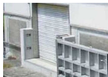
図-14 排水施設の耐水化（耐水壁の設置）
