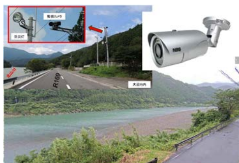
図-5 河川監視カメラの設置
