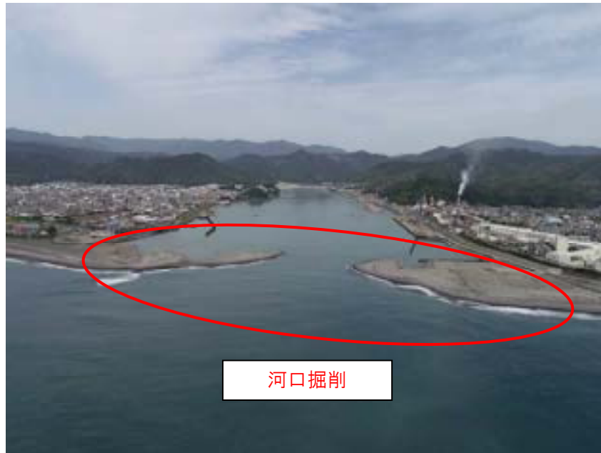
図－2.1 熊野川河口掘削（平成 30 年 11 月の状況）
