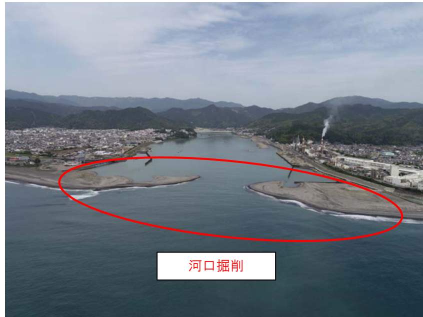
図－2.1 熊野川河口掘削（平成 30 年 11 月の状況）
