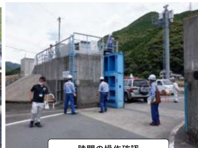
陸閘の操作確認
