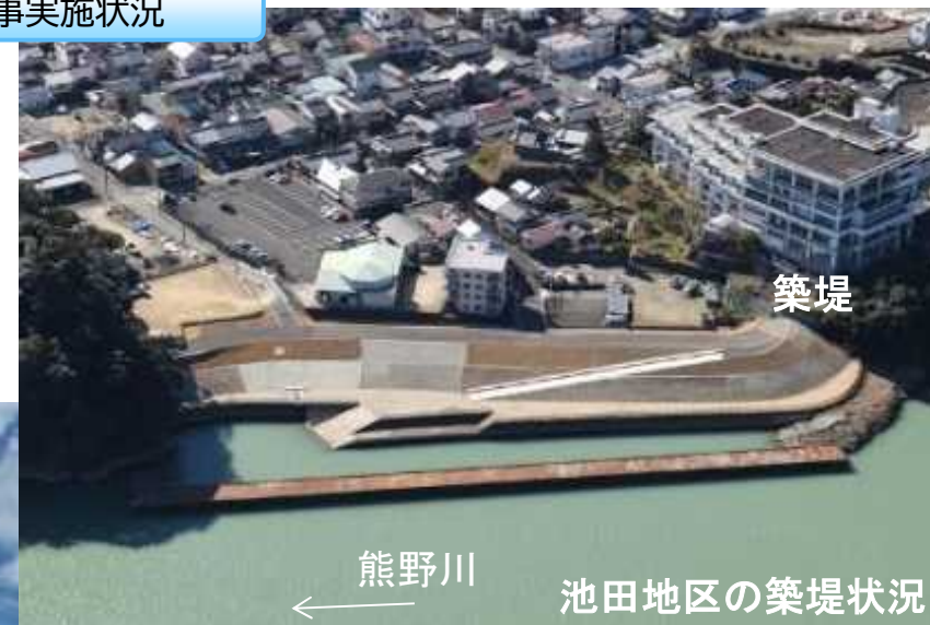
工事実施状況
