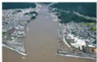
洪水時 H26.08.17撮影 相野谷川合流点 土砂堆積量(推定)約10,000m³
