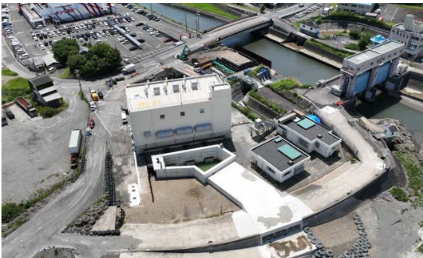
▲市田川排水機場(新設)の整備状況
