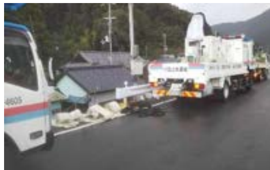
排水ポンプ車配備
