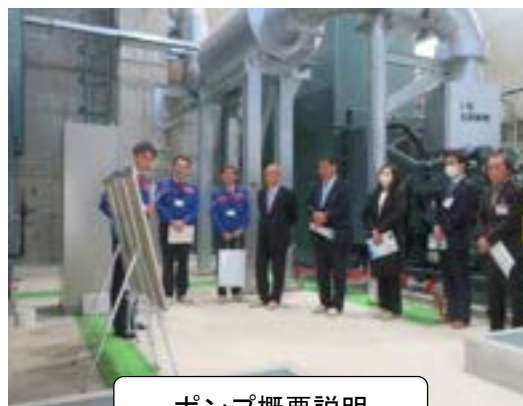
ポンプ概要説明
