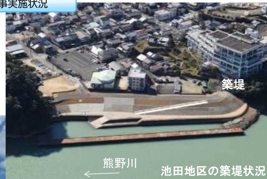
工事実施状況
