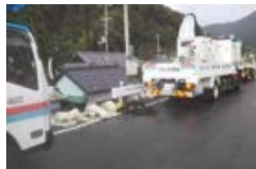
排水ポンプ車配備
