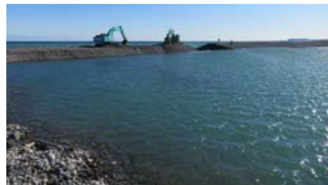
▲河口砂州掘削工事
