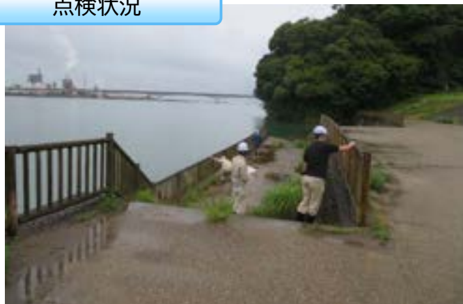
▲点検の様子（熊野川右岸1.4kp付近）
