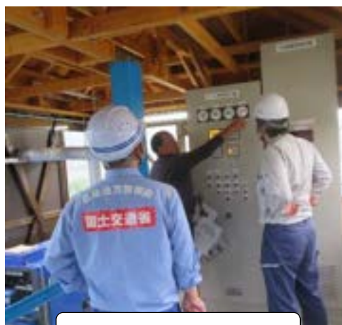
機側操作状況
