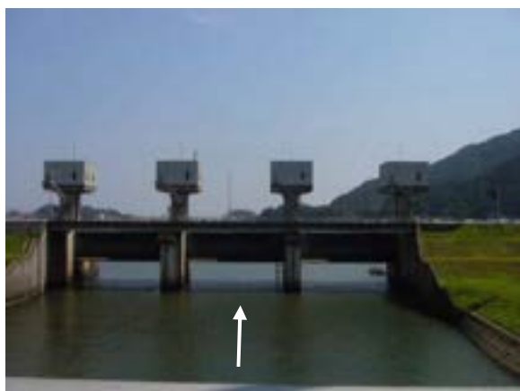
図－2.35 鮎田水門（相野谷川合流点）
