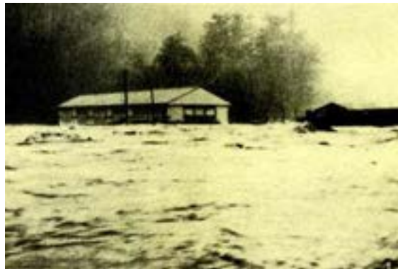
熊野川町の浸水状況
