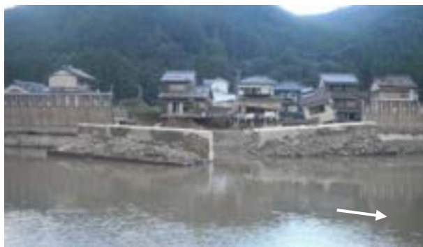
紀宝町（高岡地区）輪中堤の被災状況
