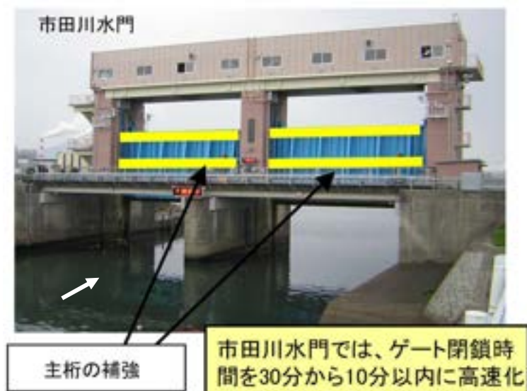
図－2.6 市田川水門における耐震対策
