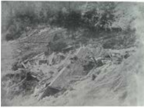
大字小森の山崩れ、家屋崩壊
