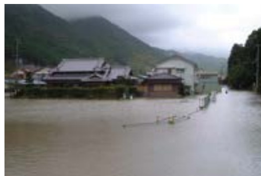
紀宝町（高岡地区）浸水状況
