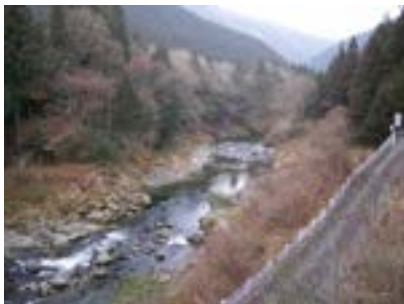
図－2.21 熊野川上流部（天川村）
