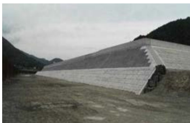
図－2.3 相野谷川輪中堤（高岡地区）
