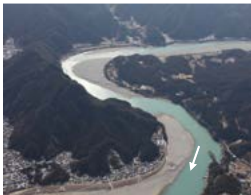
図-2.32 熊野川下流部 (令和2年11月)
