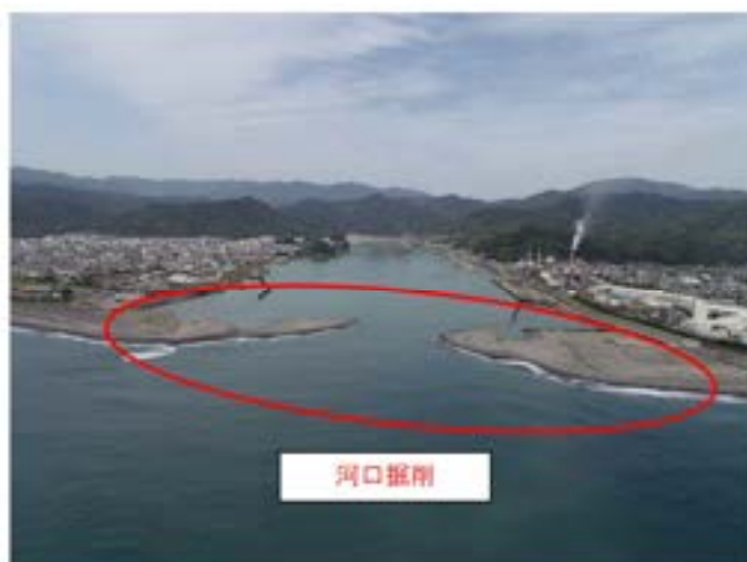
図－4.3 河口砂州掘削（平成 30 年 5 月）
