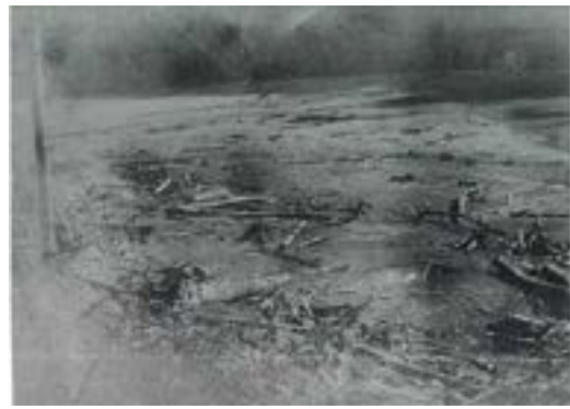
大字川津付近、洪水による家屋喪失
