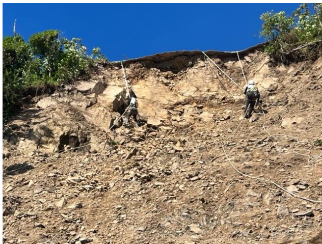
不安定な土塊の除去状況
