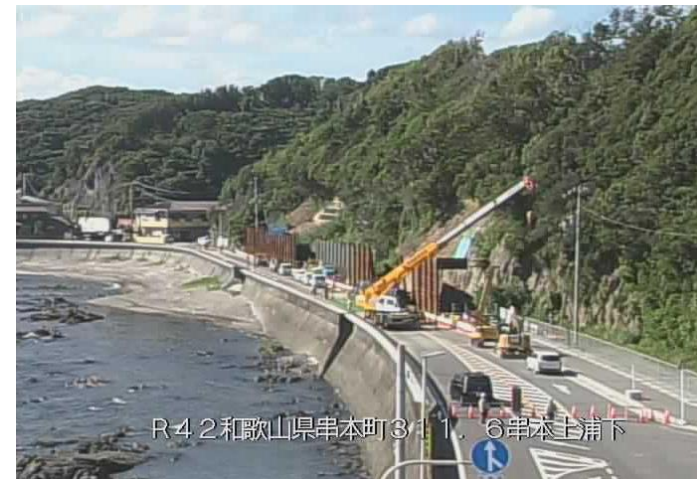
資機材等の荷揚げ状況
