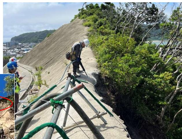
午前中 法面上部 突き出た部分の除去作業状況
