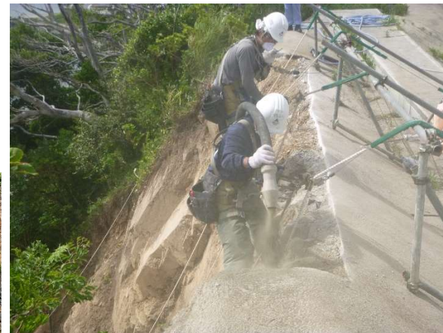
法面のモルタル吹き付け作業状況
