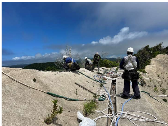
法面上部突き出た部分の除去作業状況
