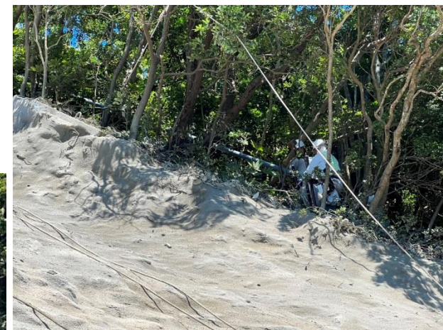
法面監視機器の設置状況
