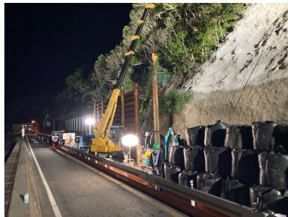
仮設防護柵設置の作業状況
