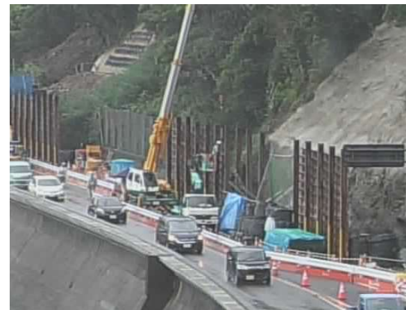
仮設防護柵設置の作業状況
