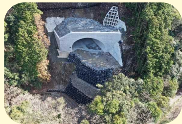
① すさみ町江住(江住第二トンネル) ちょうえすみ えすみ だいに
