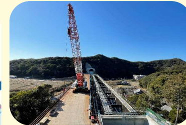
⑦ 串本町二色(二色川橋) くしもと ちょうにしきにしきがわばし
