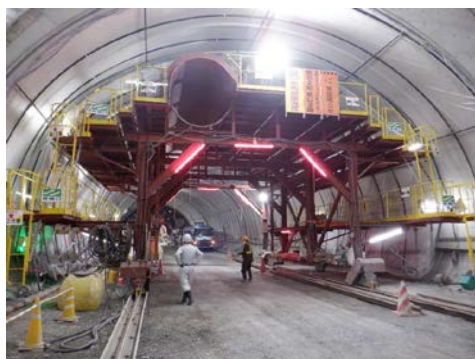
①トンネル工事現場
