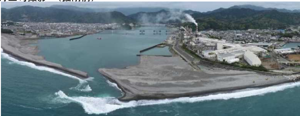
7月1日撮影 (掘削施工中)
