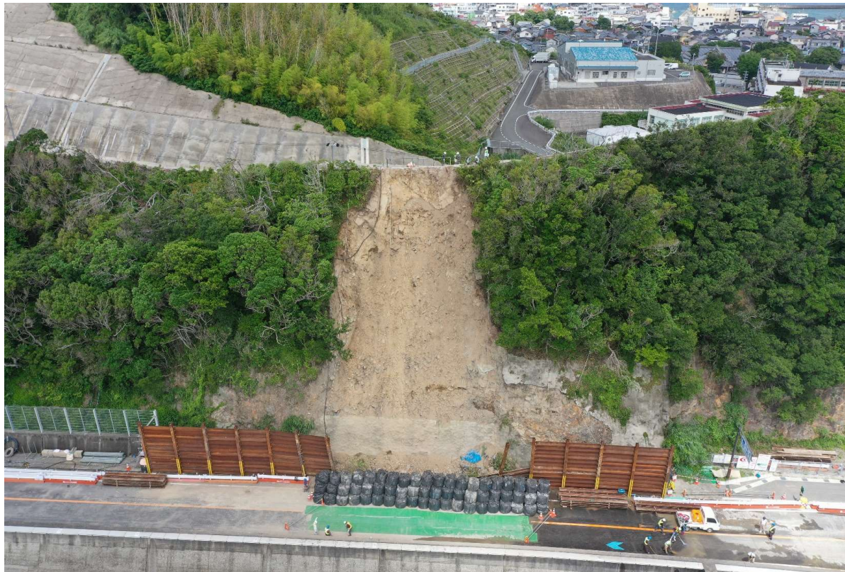
○崩土発生範囲のモルタル吹き付け(2022. 6. 30 AM6時頃)
