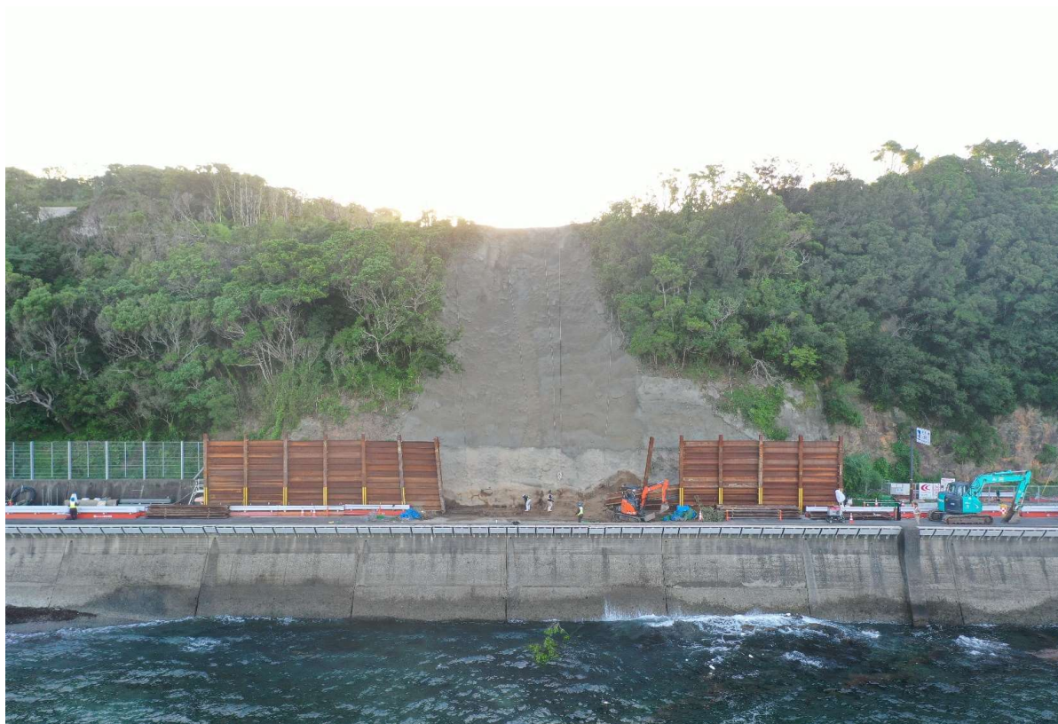
○崩土発生範囲のモルタル吹き付け(2022. 6. 30 AM6時頃)
