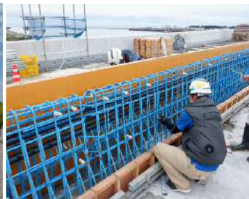
型枠組立体験
