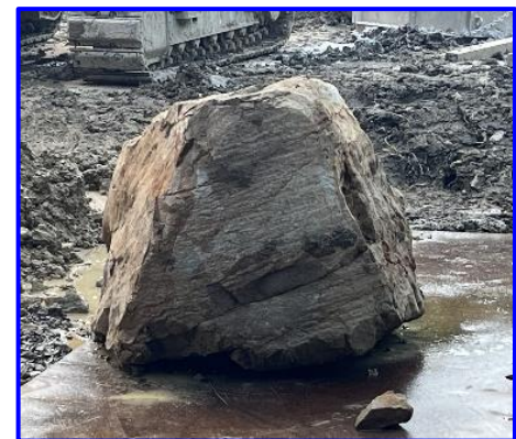
安指川橋P1施工箇所で硬質岩が出現
