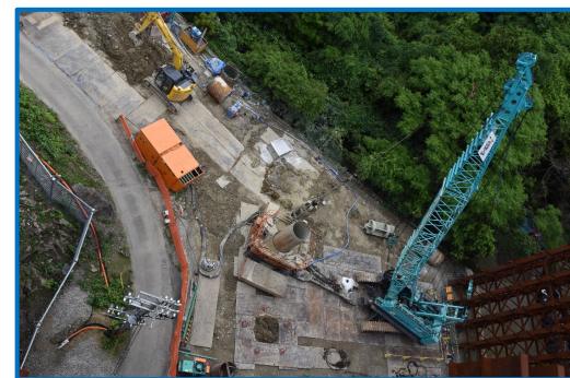
P1の施工状況（場所打ち杭）
