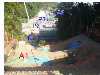
③すさみ町里野(小河瀬谷川橋)
