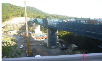
②すさみ町里野(里野西池川橋)
