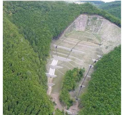
写真2 治山事業による土砂流出抑制
