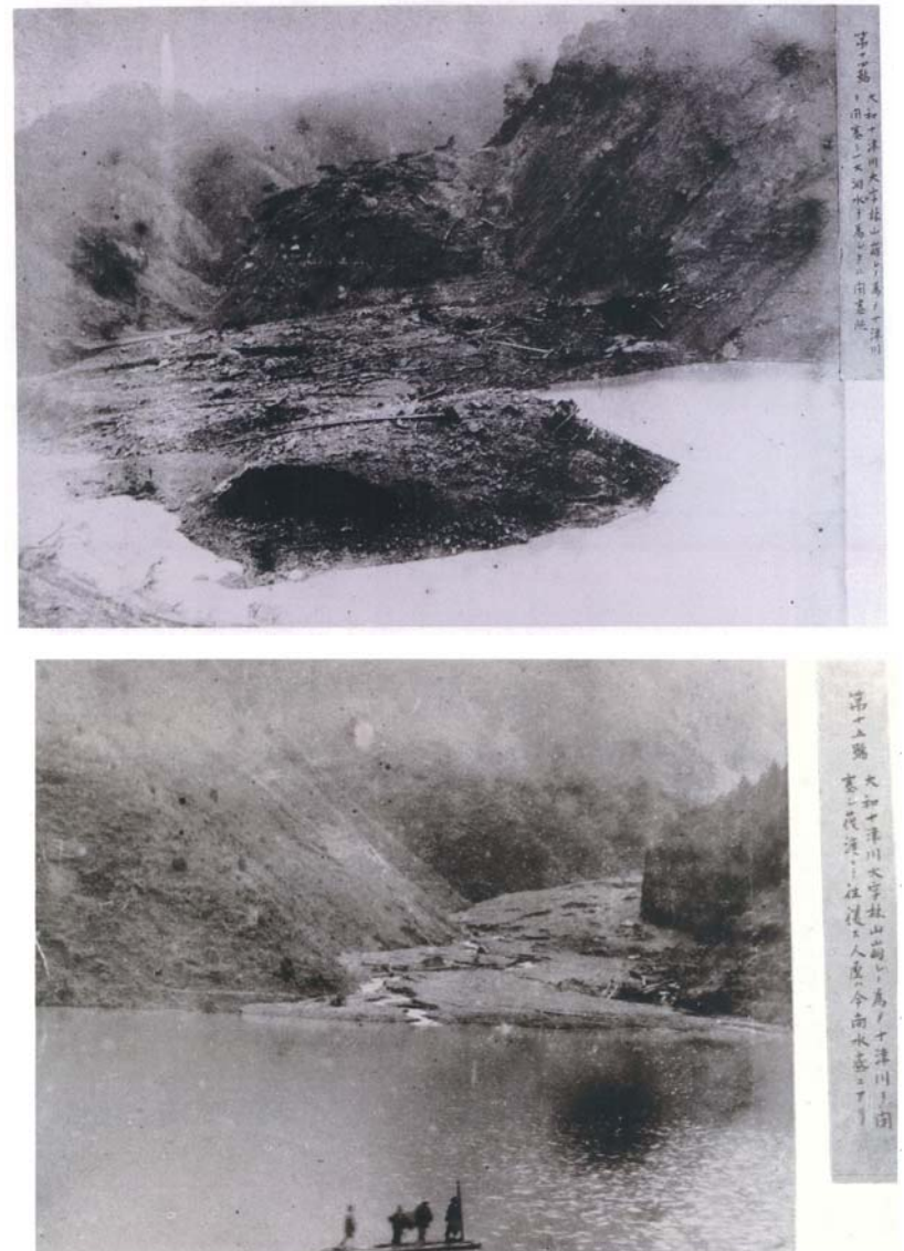
土砂崩壊による湛水湖の状況
