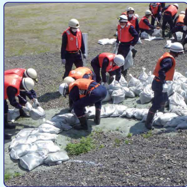
②土のうを半円状に並べる
