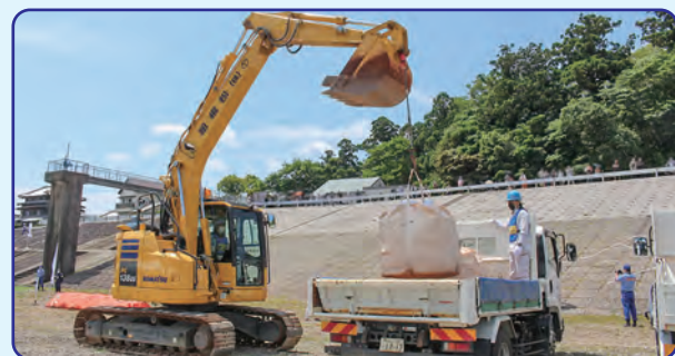
大型土のうの吊り上げ
