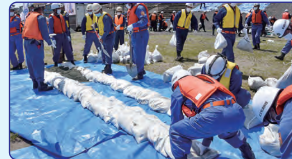
①シートを敷いて、土のうを並べる
