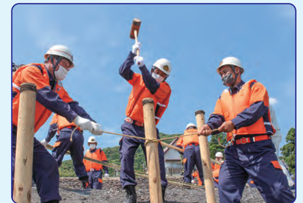
②堤防法面に固定用の杭を打ち込む
