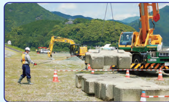
根固めブロックの吊り上げ
