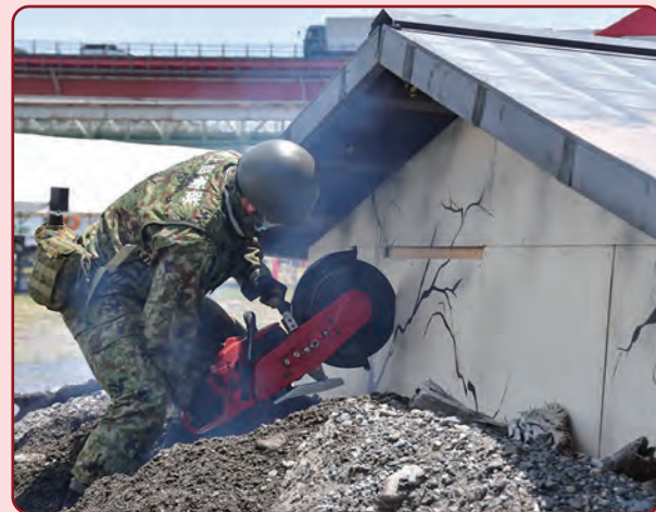
③エンジンカッターで壁面を開放する
