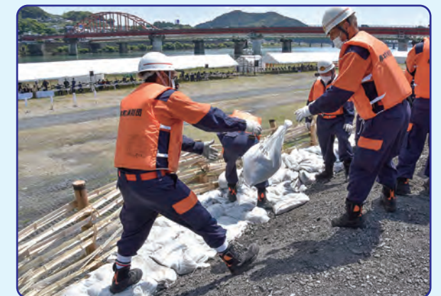
④土のうを積み上げる
