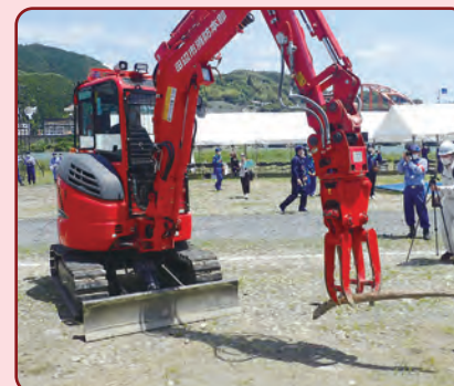
①周囲の土砂やがれきを撤去する
