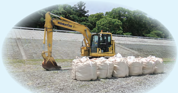
大型土のうの吊り上げ
