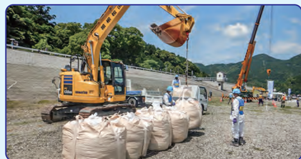
大型土のう設置の様子
