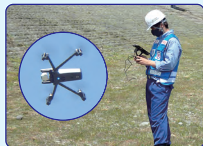
UAVによる調査
