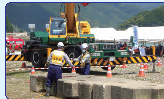
根固めブロック設置の様子
