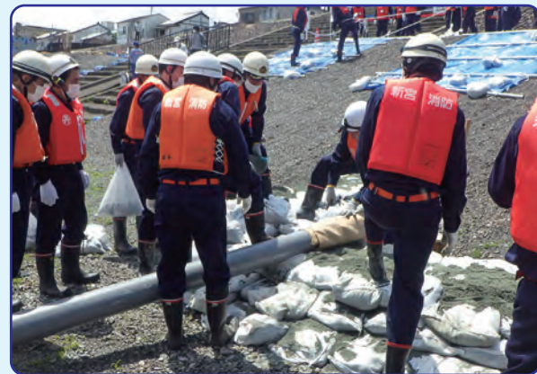
④排水パイプを取り付ける
