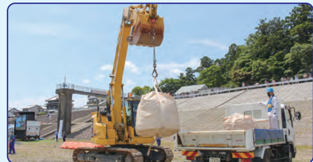
大型土のうの吊り上げ
