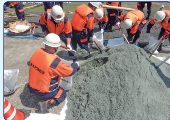
①土のうをつくる
