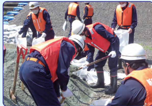
①土のうをつくる
