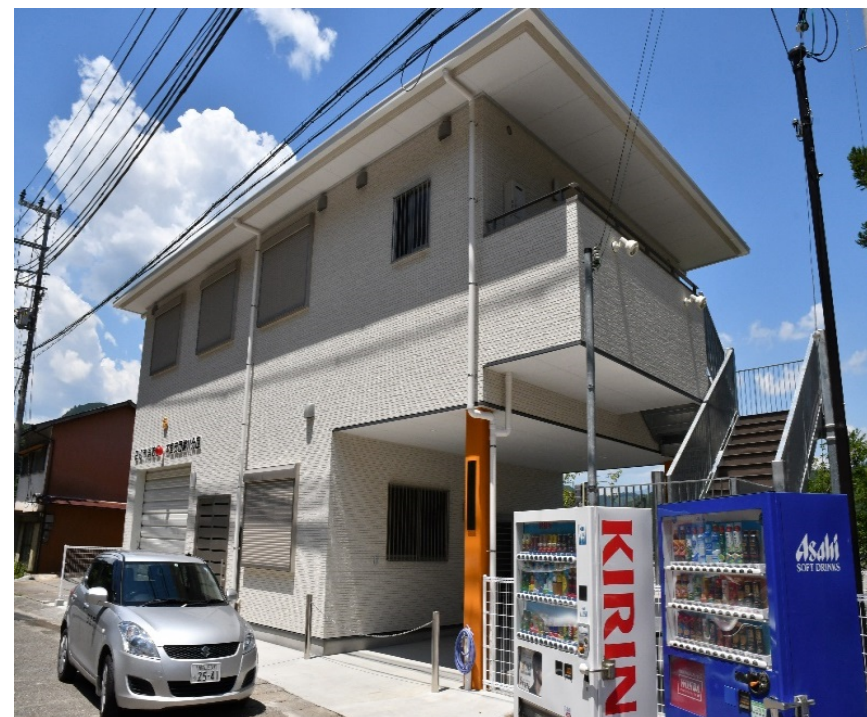
請川地域防災拠点施設
