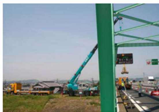
高架道路（高速道路）からの資材搬入イメージ
