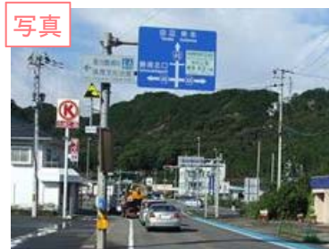
開通前: 平成26年8月19日(火) 国道42号和歌山市向き車線
