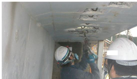
橋梁補修工事（断面修復）
