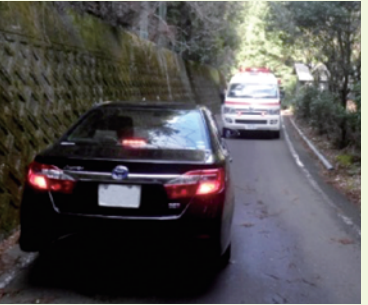
幅員が狭く、すれ違いが困難な国道169号の現況
