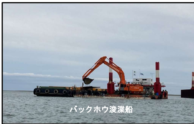
▲熊野川河道掘削
