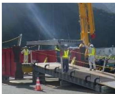
緊急仮設橋の組立
