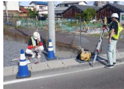
境界杭の設置状況
