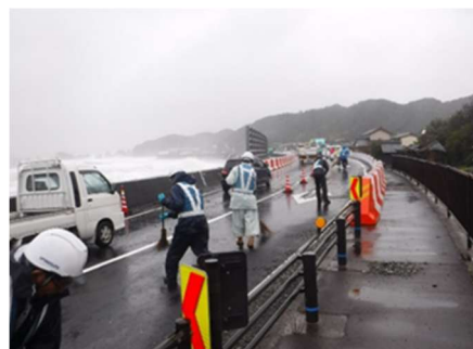
越波後の路面清掃
