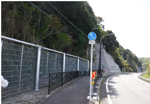
落石防護柵工
