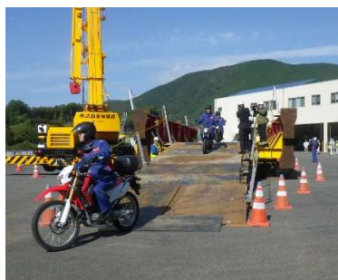
緊急仮設橋組立後の走行
