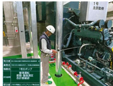
排水機場の点検
