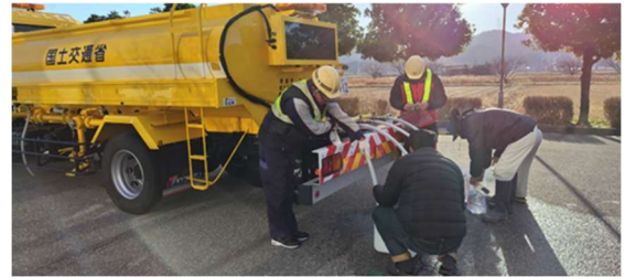
中能登町での給水状況
