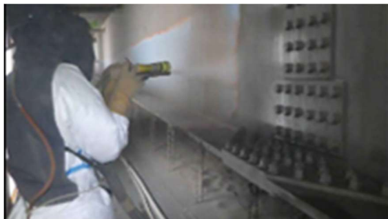
橋梁補修工事（塗替塗装）
