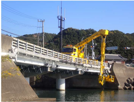
橋梁点検車による点検
