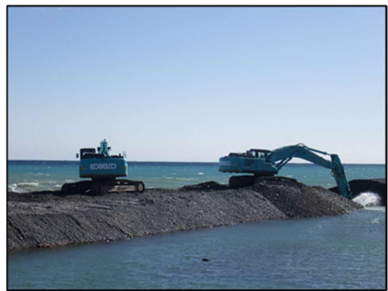
▲河口部砂州掘削
