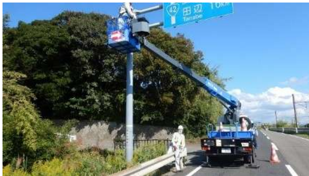
道路標識の点検
