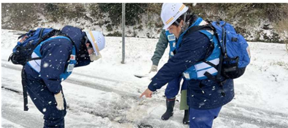
珠洲市での被災状況調査
