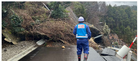
輪島市での被災状況調査
