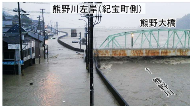
(1) 紀伊半島大水害(H23.9)の被害状況
