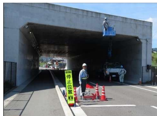
カルバートの点検
