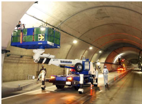
近接目視点検
