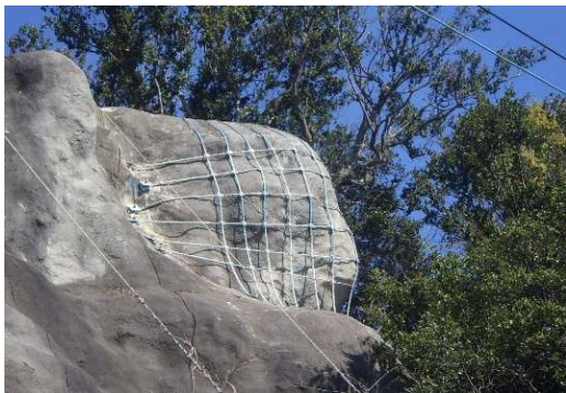
ワイヤーロープ掛工
