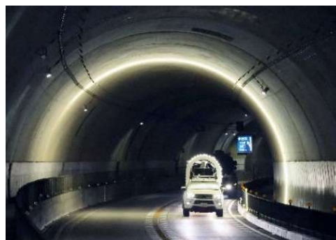
新技術の活用 （自走式測定車による点検）
