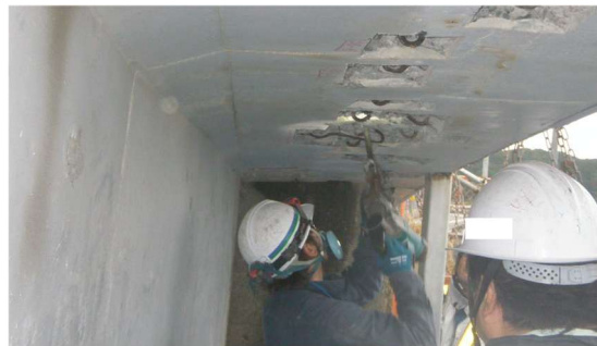
橋梁補修工事（断面修復）
