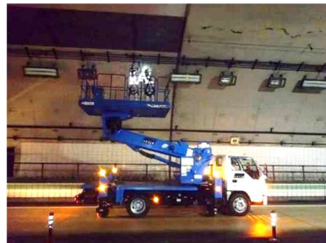
道路照明施設の点検
