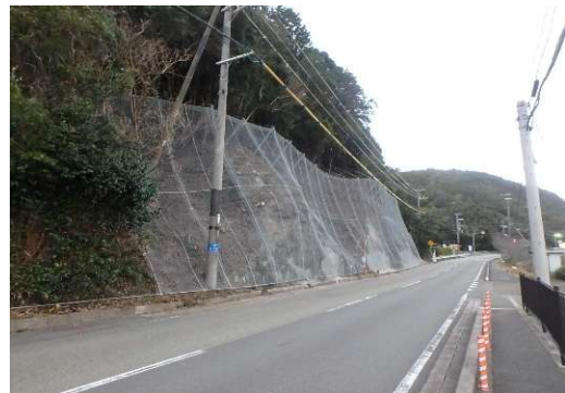
ポケット式落石防止網工
